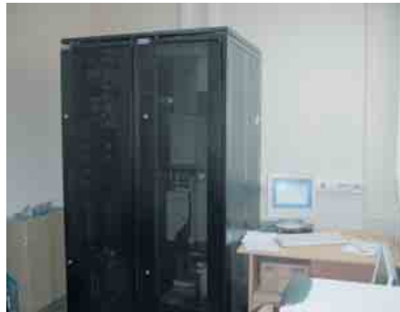
Серверное и коммуникационное оборудование Мурманской территориальной АСКРО
