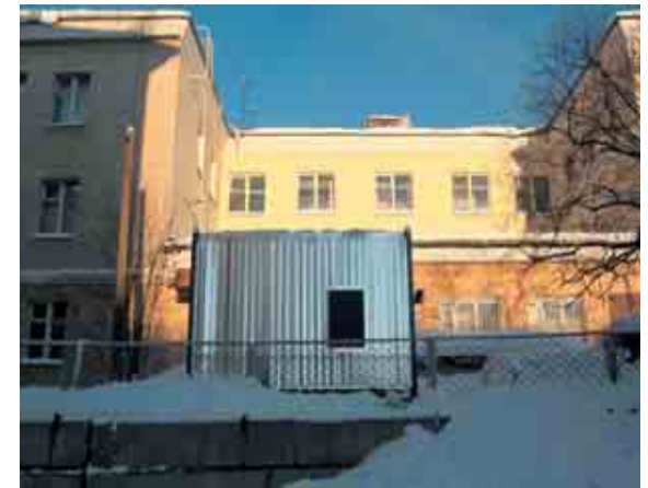
Контейнер с дизель-генераторной установкой
