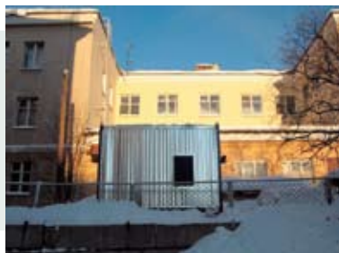
Контейнер с дизель-генераторной установкой
