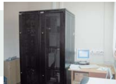
Серверное и коммуникационное оборудование Мурманской территориальной АСКРО
