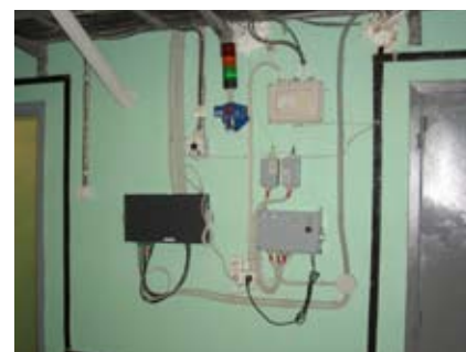
Блок аварийной сигнализации БАС, блоки сопряжения БС-11, блок обработки и передачи данных БОП-1М
