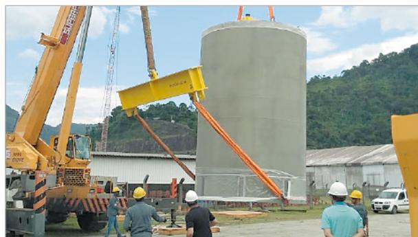
Рис. 2. Один из пяти первых модулей для сухого хранения ОЯТ, доставленных на площадку АЭС Ангра
