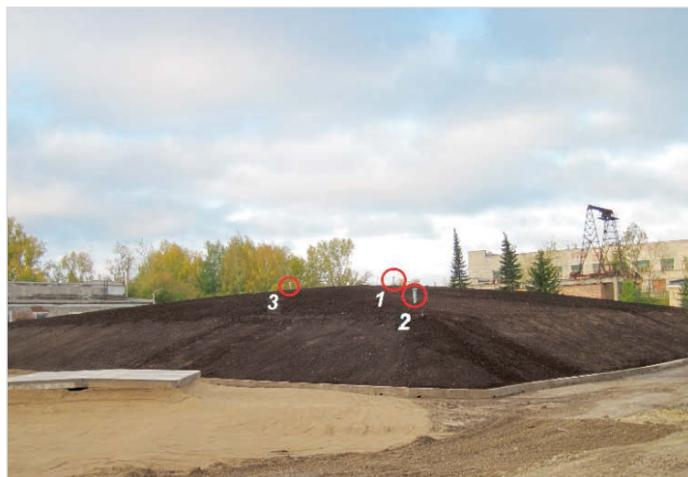
Рис. 5. Система инспекционных каналов в ПХ РАО ЭИ-2
