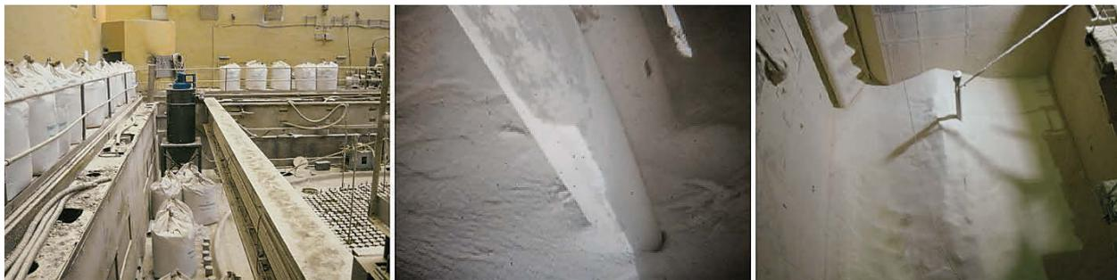
Рис. 3. Создание дополнительных барьеров безопасности в шахте ПУГР ЭИ-2: вид центрального зала при заполнении (слева), барьерный материал в полостях шахты реактора (центр), инспекционный канал в технологической шахте (справа)
