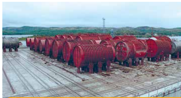
На 1.04.2018 установлено 107 реакторных отсеков
