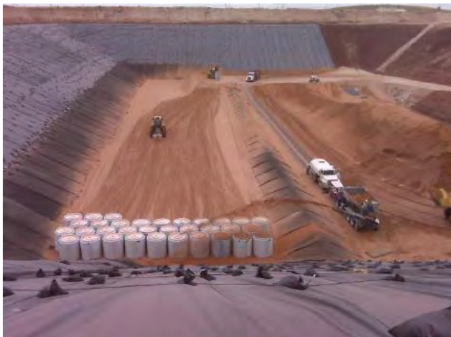
Рисунок 1.14 – Захоронение РАО в штате Техас, США [105] (слева – засыпка упаковок РАО глиной, справа – схема размещения сооружений захоронения)
