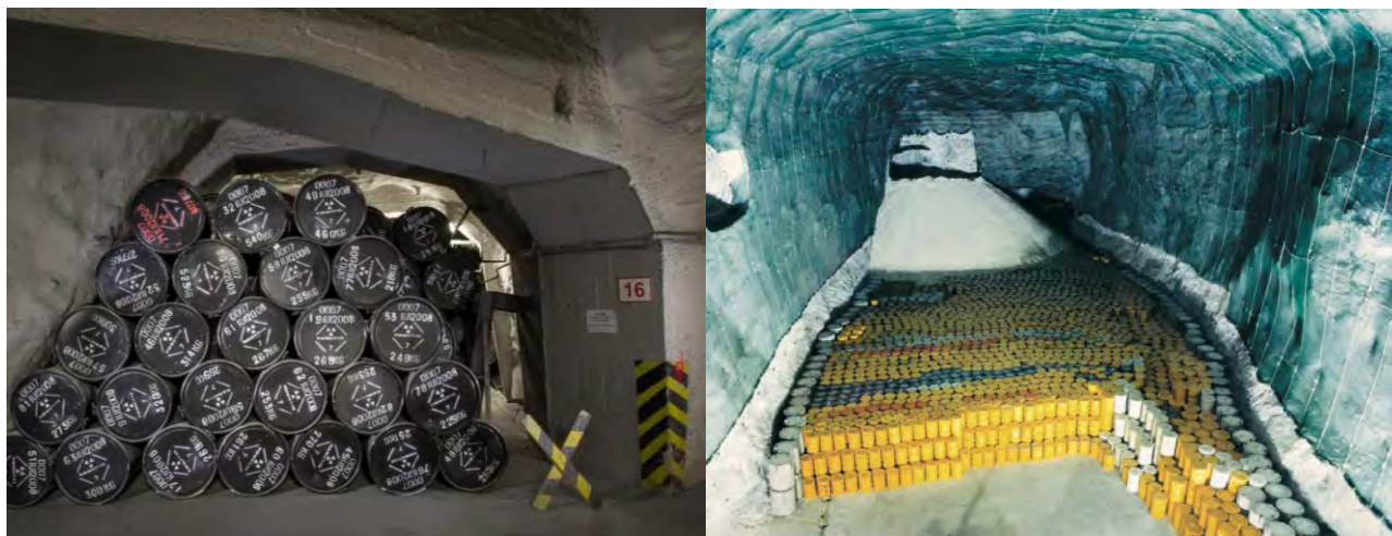
Рисунок 1.24 – Подземные сооружения захоронения в закрытых рудниках по добыче полезных ископаемых (слева – ПЗРО Richard, Чехия [125], справа - ПЗРО Morsleben, Германия) [127]
