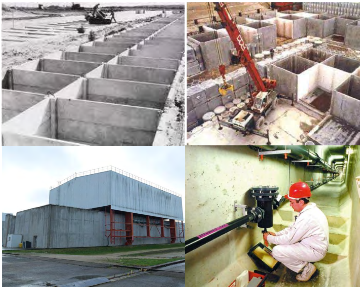
Рисунок 1.30 – Тенденции по выбору технологий захоронения РАО во Франции (вверху слева – захоронение РАО в заглубленных траншеях (1969 г.); вверху справа – захоронение РАО на открытом воздухе на наземном бетонном основании (1985 г.); внизу – современный наземный ПЗРО с бетонными отсеками, укрытием для защиты от осадков, и инспекционной галереей для сбора и контроля протечек (внизу справа показан отбор проб в инспекционной галерее) [80]
