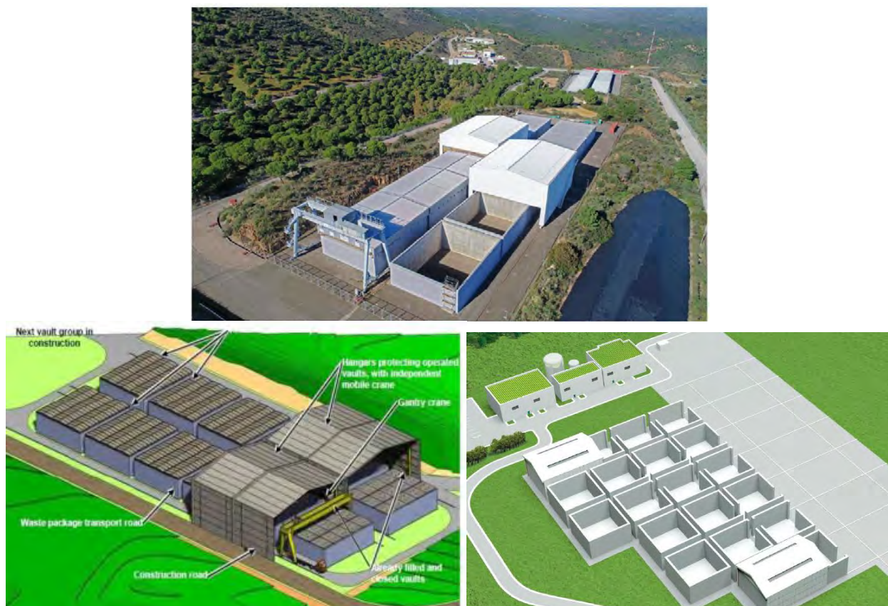
Рисунок 1.8 – Наземные сооружения захоронения в Испании (сверху) [85], Литве (внизу слева) [88] и Корее (внизу справа) [91]
