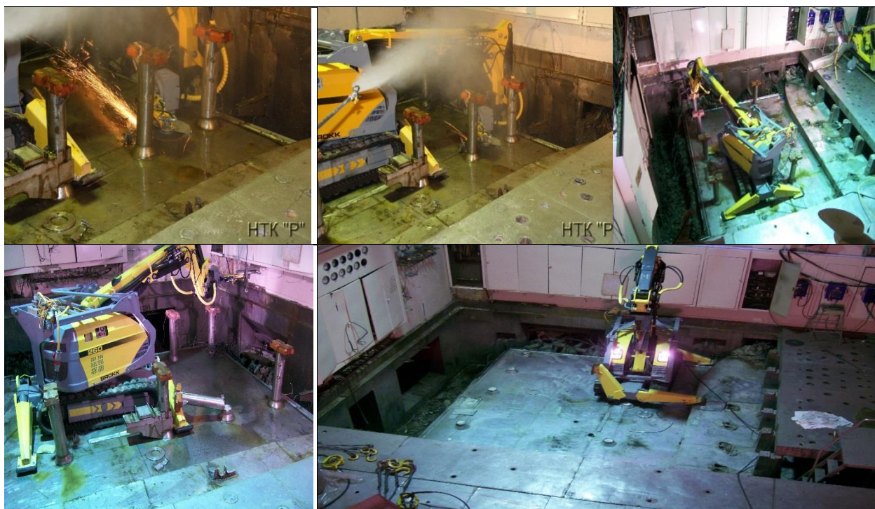
Рисунок 4.16 - Вид поднастильного пространства в процессе и по окончании демонтажных работ
