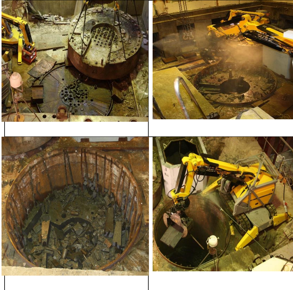
Рисунок 4.23 - Выгрузка графитовой кладки из реактора РФТ
