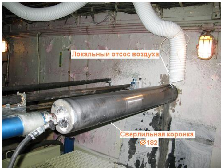
Рисунок 2.49 - Бурение скважины в биологической защите реактора РФТ
