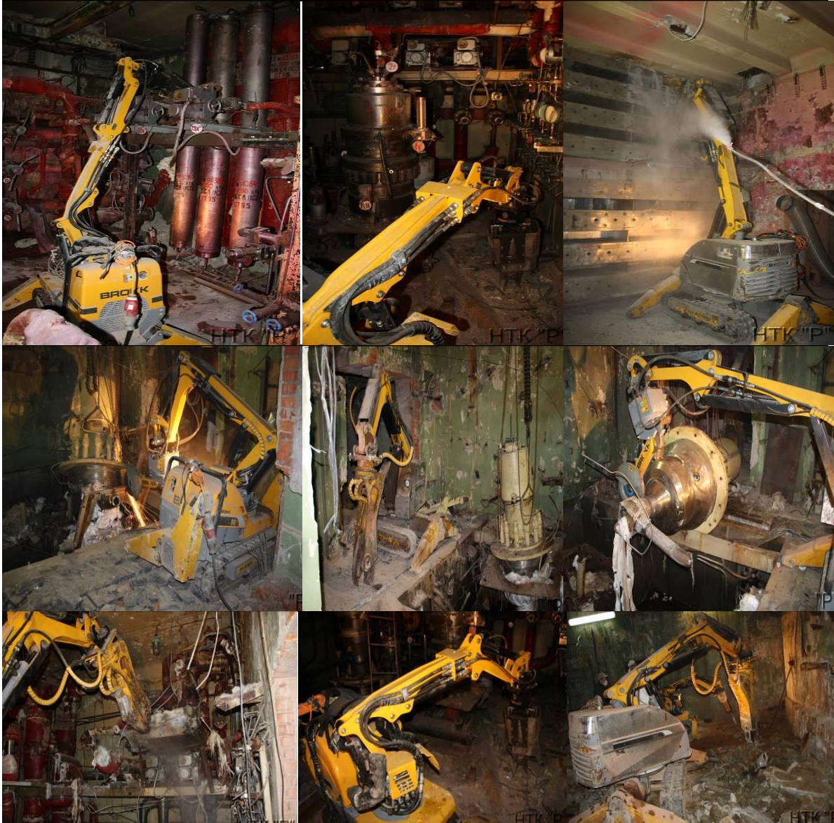
Рисунок 4.10 - Демонтажные работы в технологических помещениях, выполняемые с помощью дистанционно-управляемых механизмов
