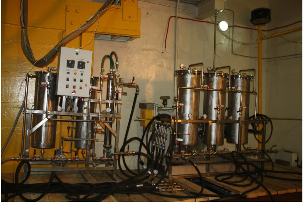
Рисунок 4.5 - Установка «Аква - Экспресс», смонтированная в реакторном зале
