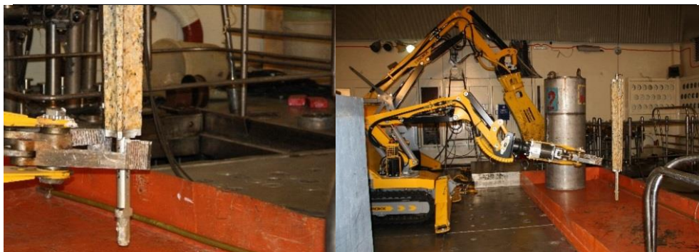
Рисунок 4.20 - Отделение алюминиевого хвостовика и загрузка бериллиевого блока в свинцовый перегрузочный контейнер
