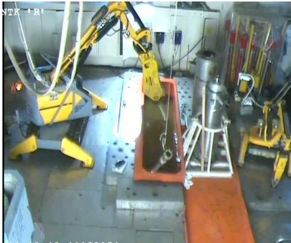
Рисунок 4.3 - Процесс отделения активной части канала под водой с помощью дистанционно-управляемого механизма «BROKK-180»
