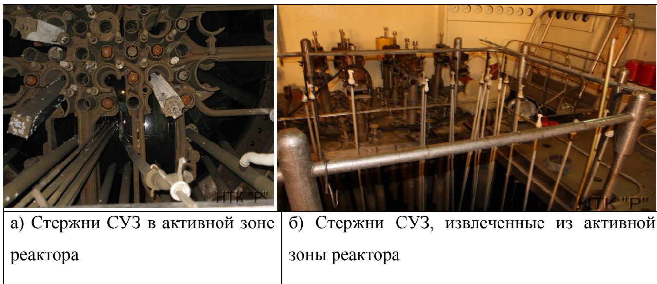
Рисунок 4.17 - Вид бассейна реактора МР со стержнями СУЗ
