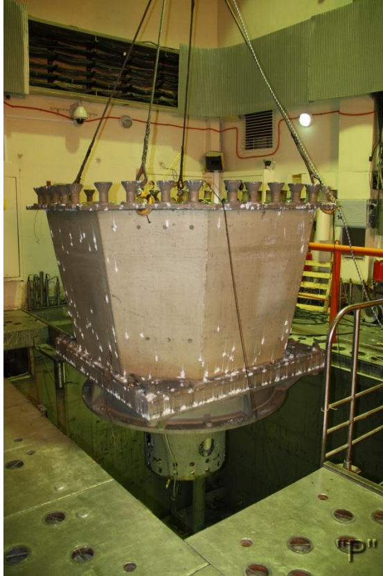
Рисунок 4.22 - Демонтаж корпуса реактора МР
