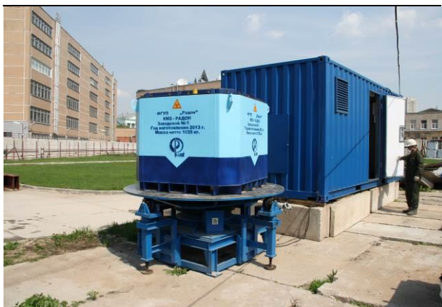
Рисунок 4.33 - Участок выходного контроля транспортных контейнеров, загруженных РАО
