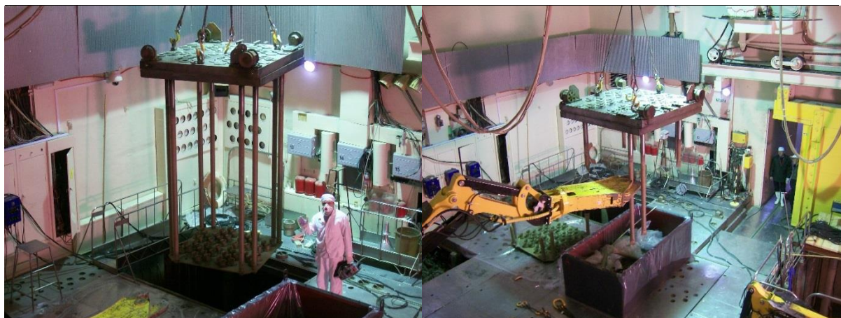
Рисунок 4.19 - Демонтаж тележки СУЗ реактора МР
