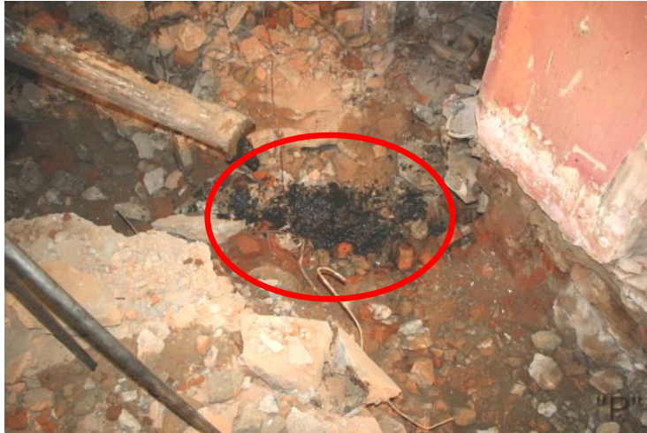
Рисунок 4.28 - Фотография части разрушенного трубопровода в помещении № 39
