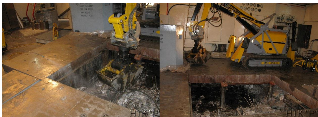
Рисунок 4.15 - Вид на опорные стойки и плакировку поднастильного пространства реактора МР
