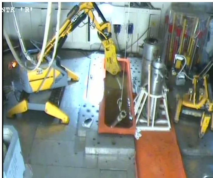
Рисунок 9 - Процесс отделения активной части канала под водой с помощью дистанционно управляемого механизма «BROKK-180»
