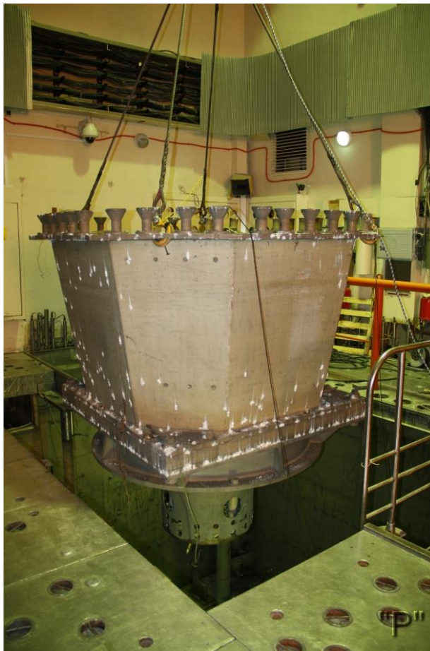
Рисунок 12 - Демонтаж корпуса реактора МР
