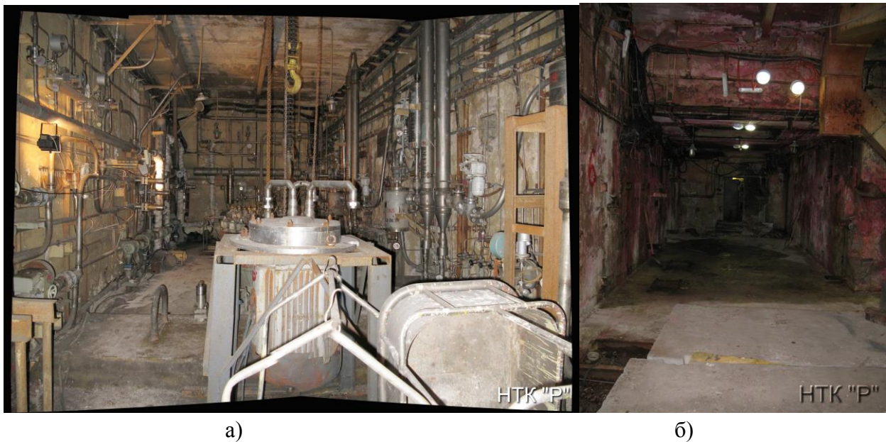
а) Рисунок 11 - Помещение петлевой установки ПГ а) – до и б) - после демонтажа оборудования
