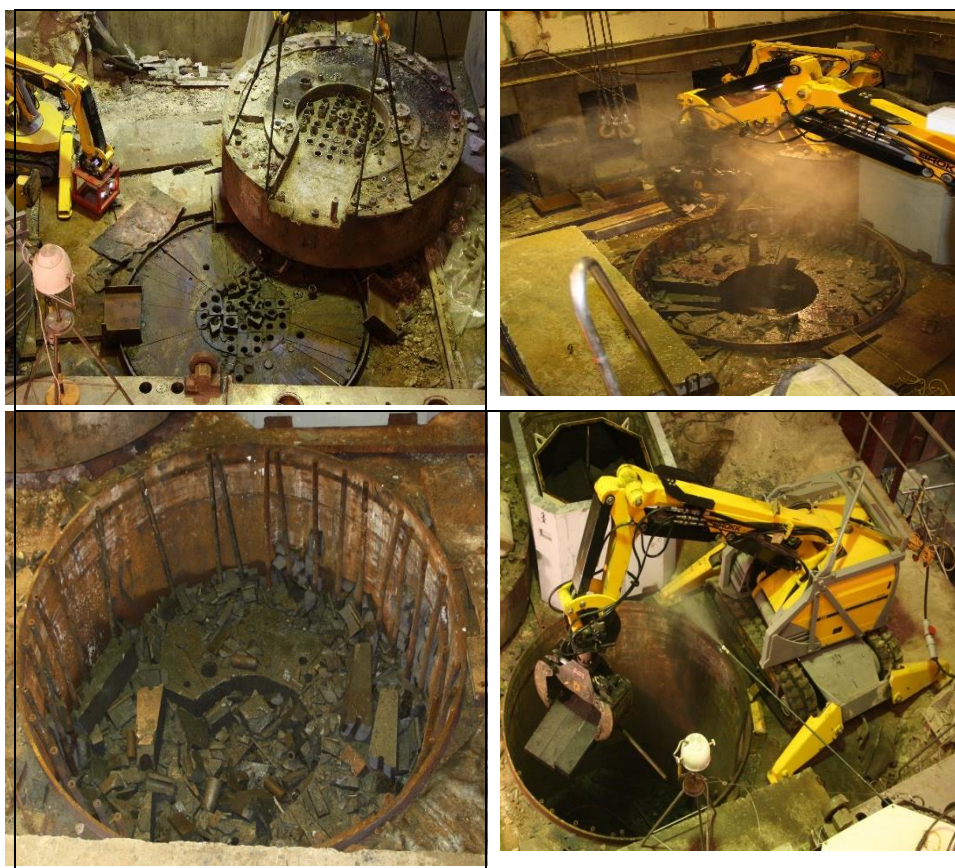
Рисунок 13 - Выгрузка графитовой кладки из реактора РФТ
