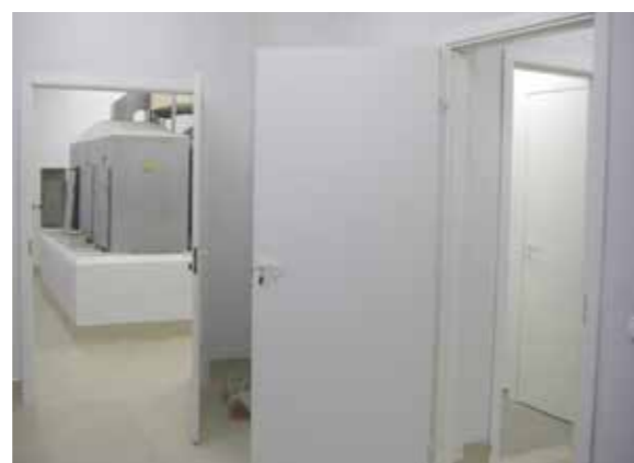
Состояние муфельной для сжигания ТРО после модернизации в ИБ Коми НЦ УрО
