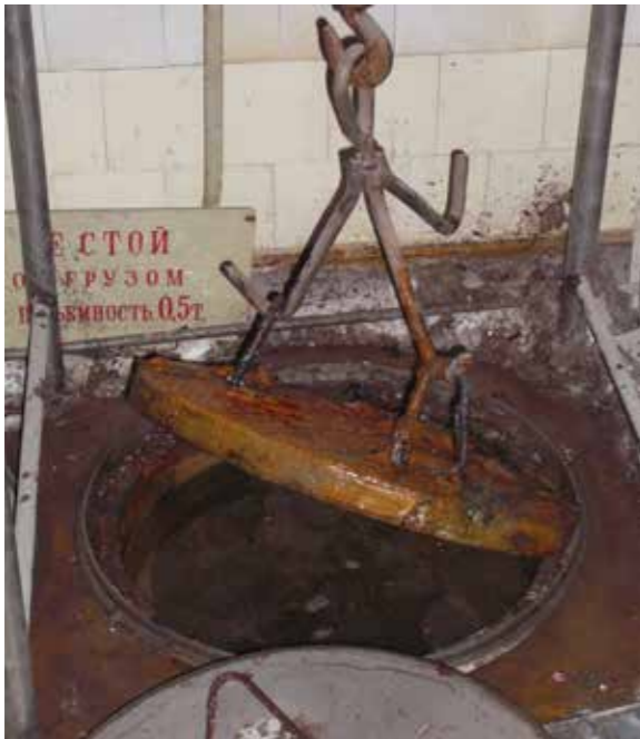
Состояние емкостей ЖРО в ИФХЭ до начала работ по дезактивации
