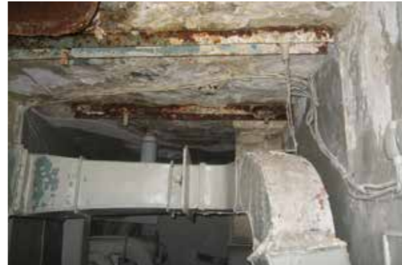
Состояние элементов спецвентиляции в ИГЕМ
