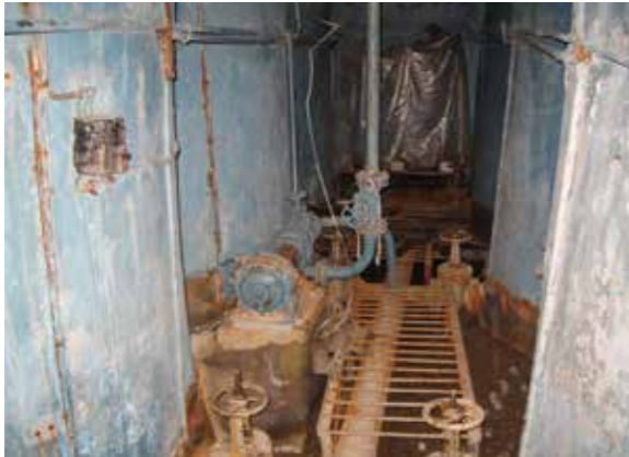
Состояние элементов спецканализации в ИХТРЕМС КНЦ
