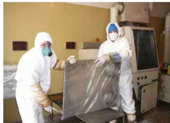
Демонтаж загрязненного оборудования в ИФХЭ
