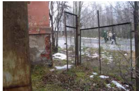
Состояние ограждения (элемента физической защиты) ИХТРЕМС КНЦ
