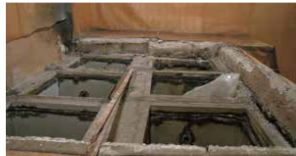
Состояние колодцев для хранения РАО во ФТИ до начала демонтажа
