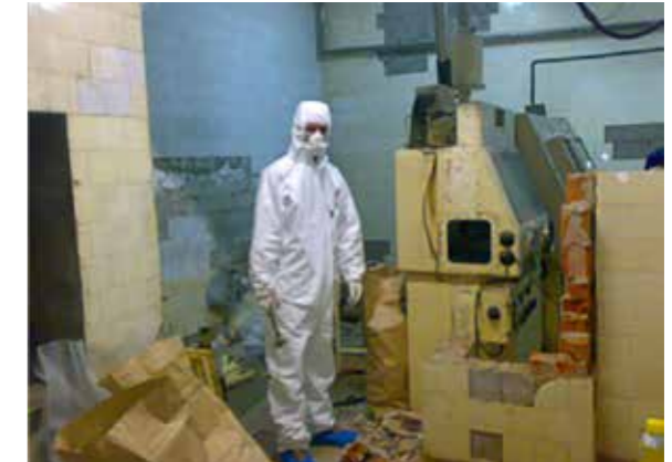
Подготовка оборудования к утилизации в ИФХЭ
