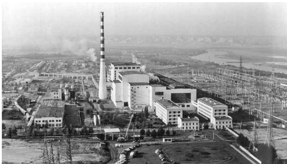
Рис. 2.118. Первые два энергоблока НВАЭС
