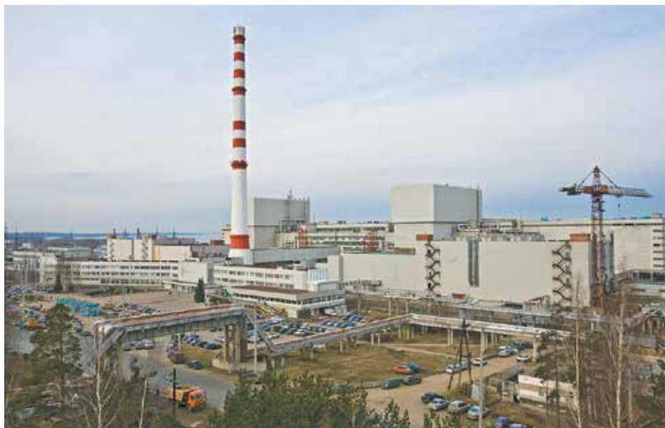
Рис. 2.159. Первая очередь ЛАЭС [16]
