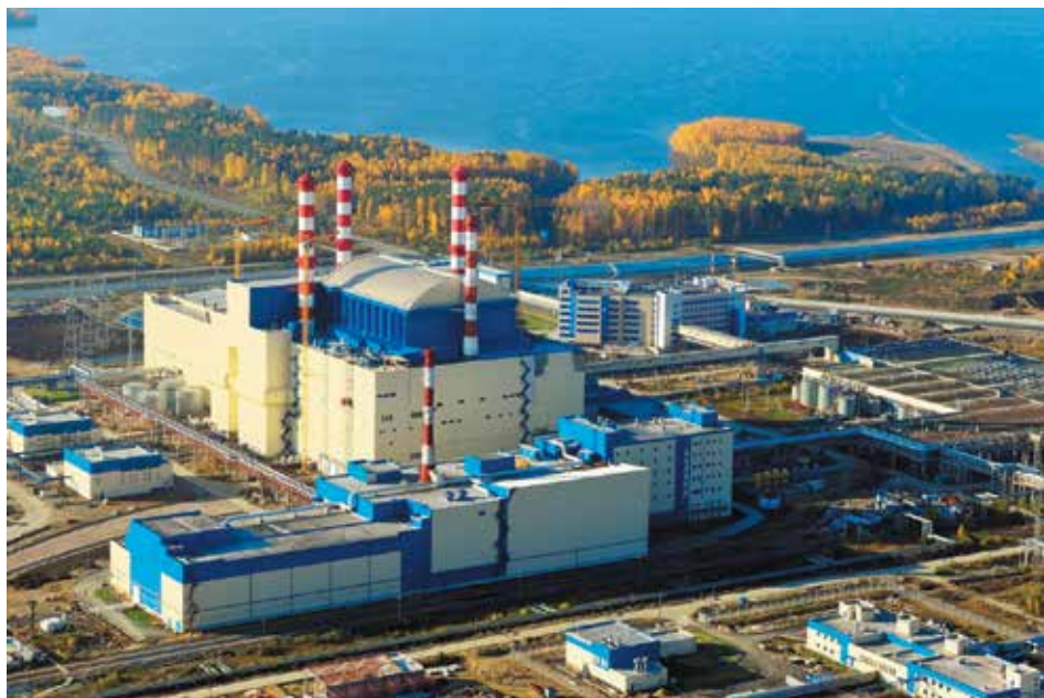
Рис. 2.102. БАЭС. БН-800 (фото из [9])
