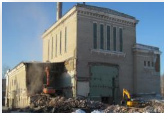
Дезактивация и демонтаж строительных конструкций
